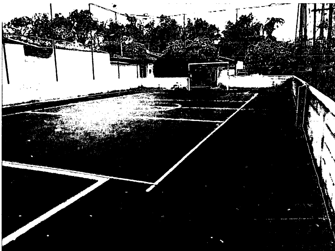
Imagem 10: Vista da quadra esportiva.
