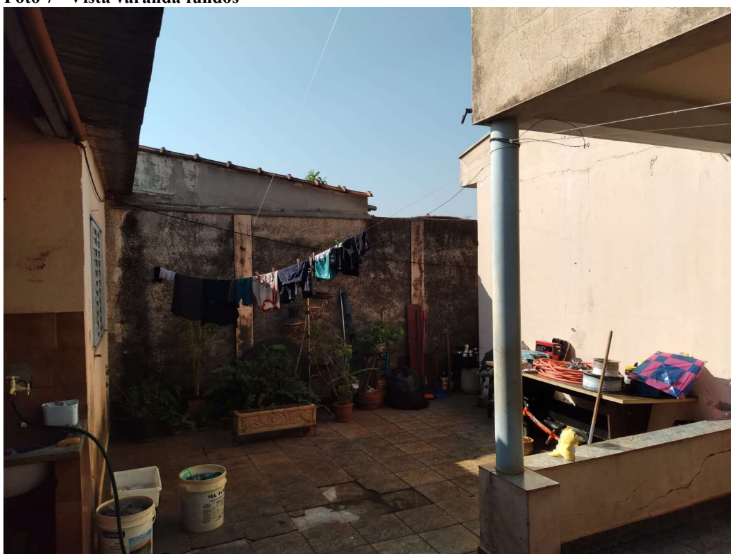
Foto 8 - Vista da varanda para a edificação principal.
