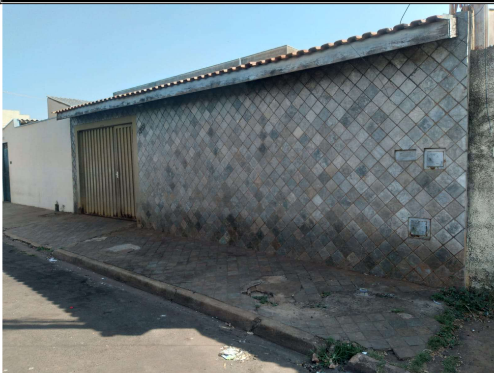
Foto 1 - Fachada do imóvel.
