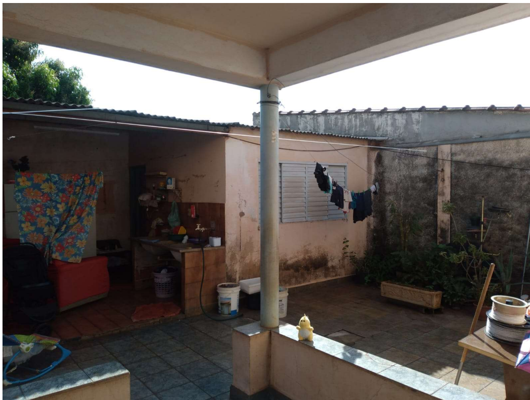
Foto 7 - Vista varanda fundos
