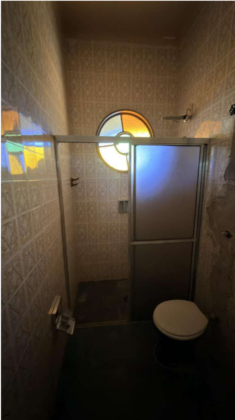
Figura 15- Vista banheiro suite 1 edícula frontal
