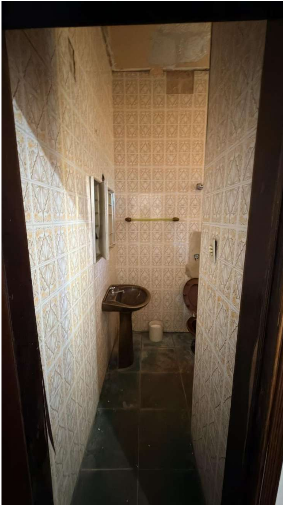
Figura 18- Vista banheiro suíte 2 edícula frontal
