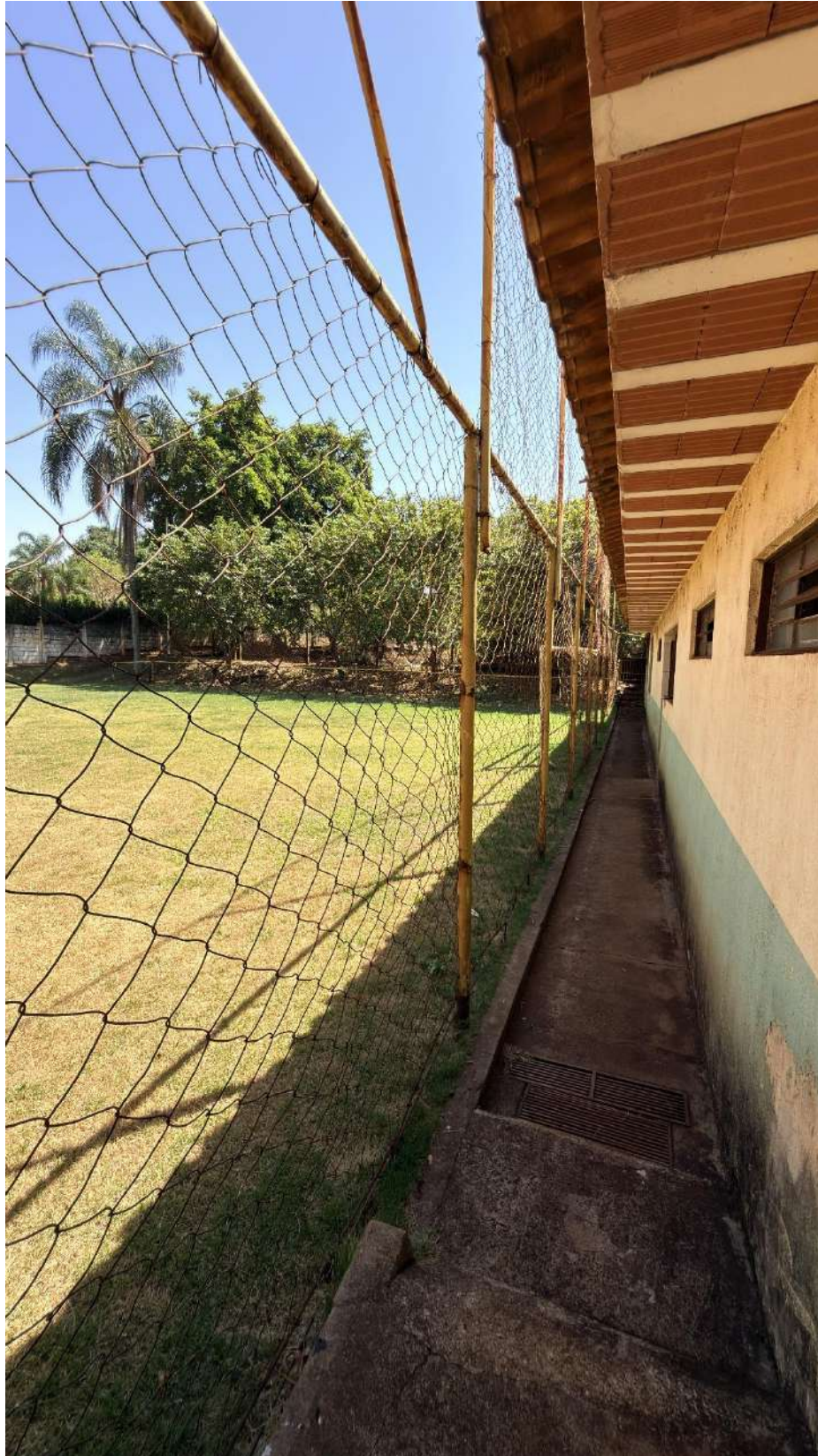
Figura 32 - Vista lateral campo, acesso fundos
