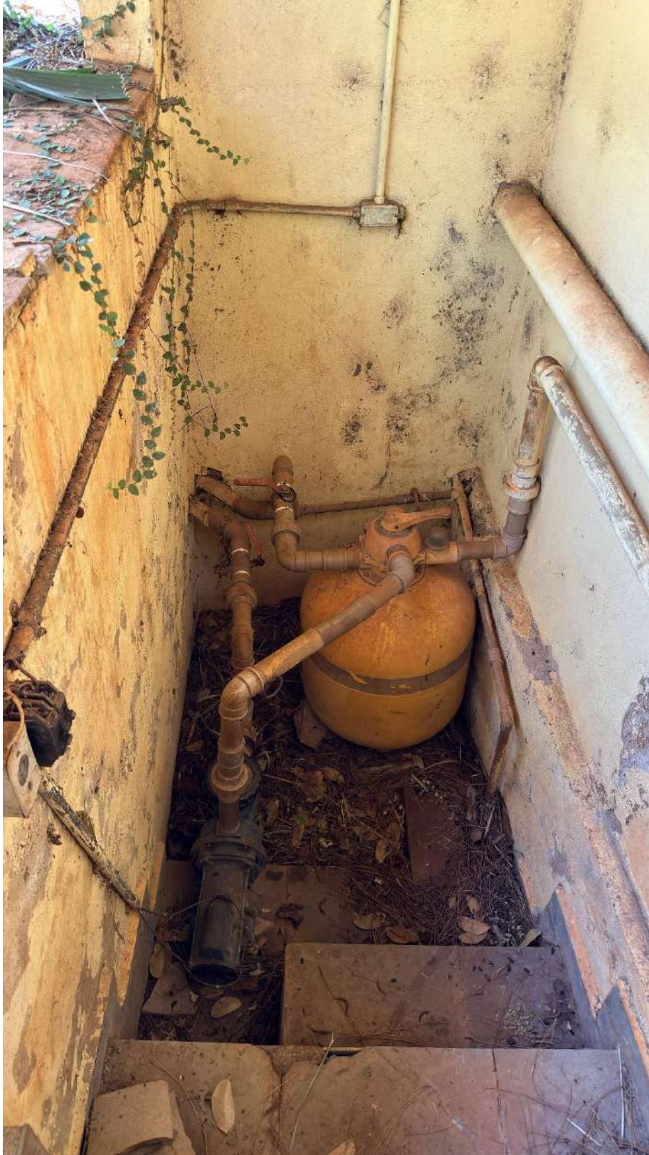
Figura 21 - Vista casa de máquina piscina
