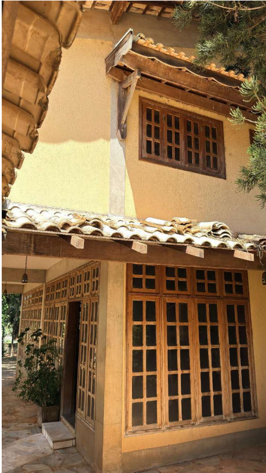
Figura 51 - Vista lateral residência
