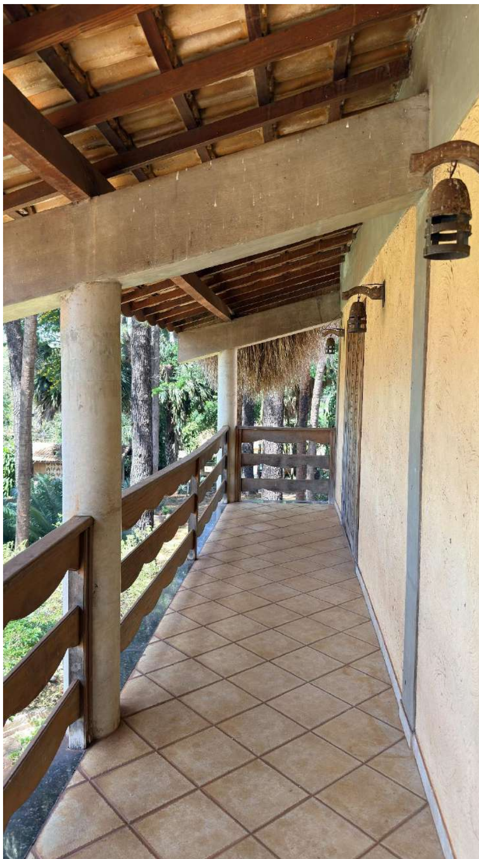
Figura 61 - Vista sacada lateral
