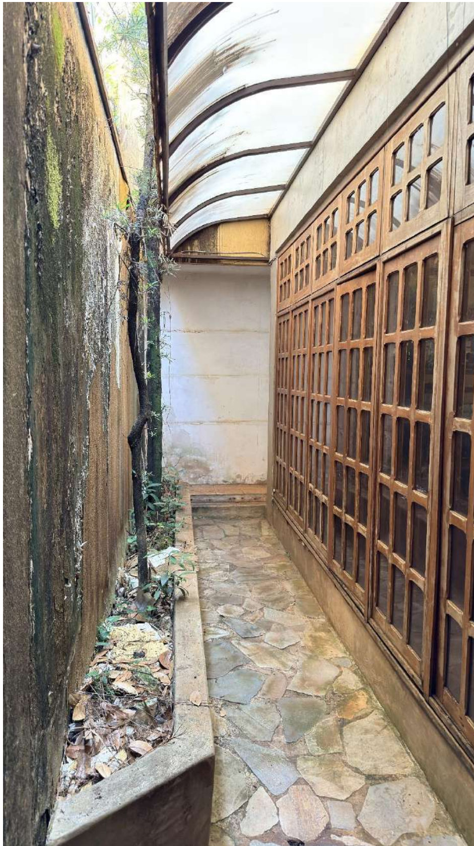
Figura 56 - Vista claraboia, vazamentos e mofo
