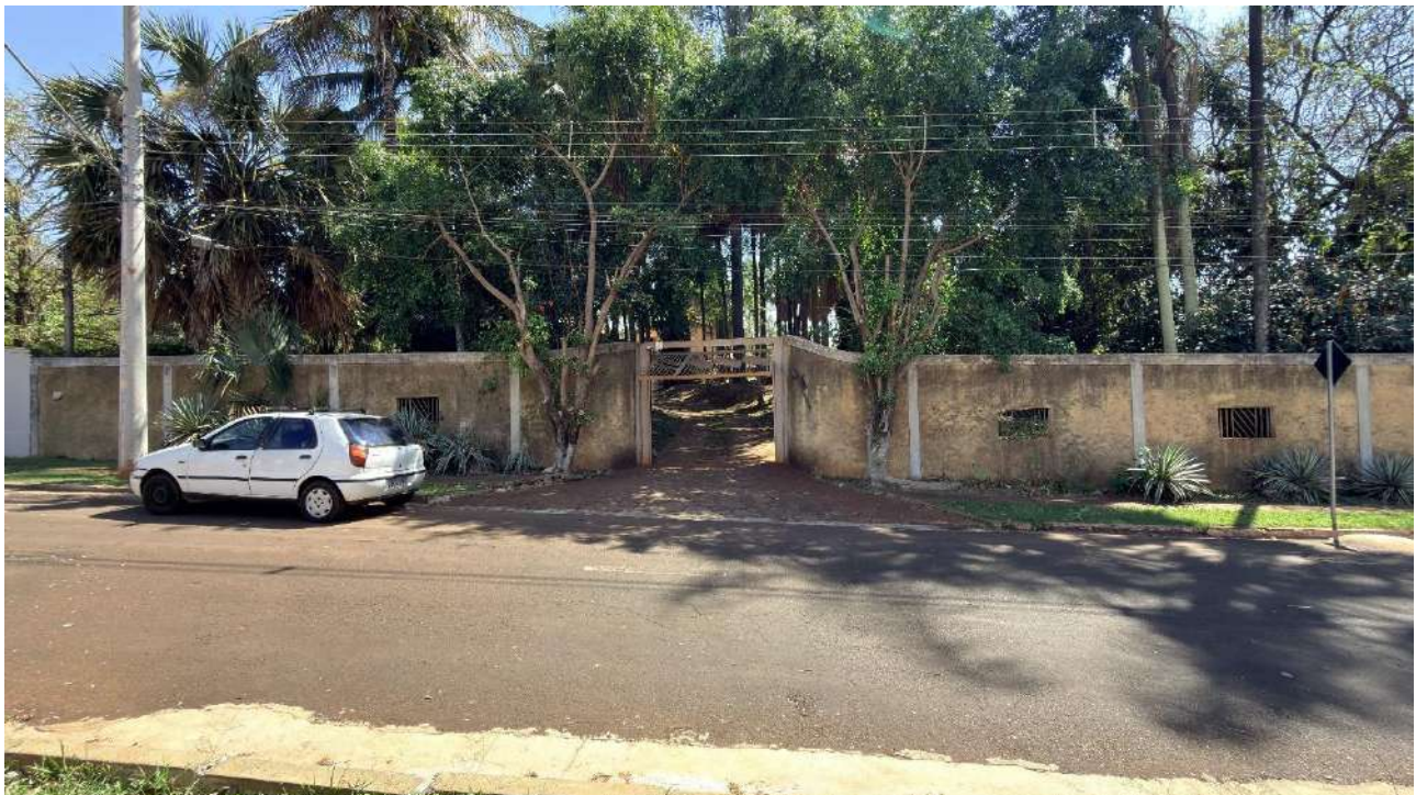
Figura 3 - Vista de frente ao lote vistoriado
