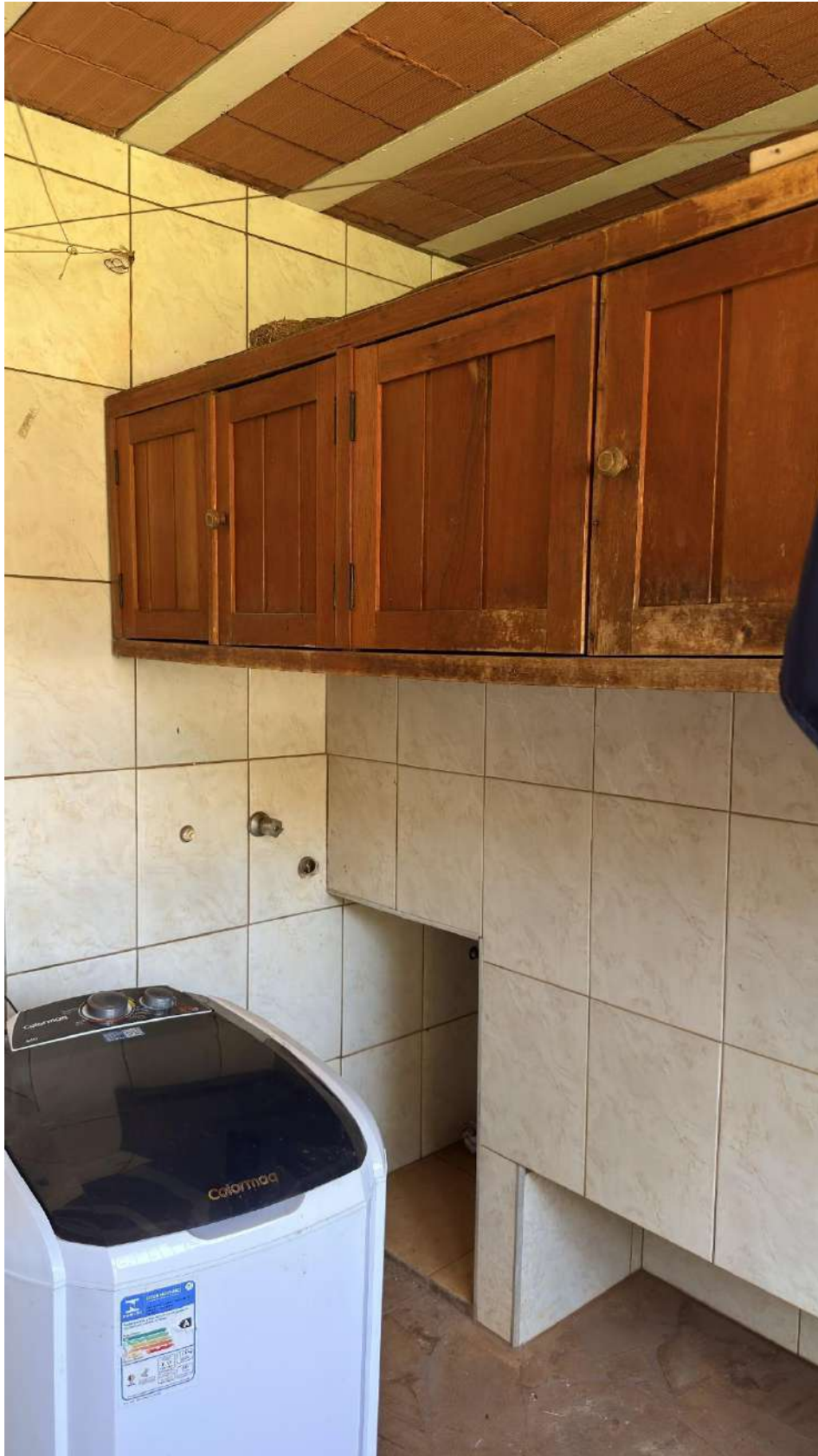
Figura 34 - Vista área de serviços
