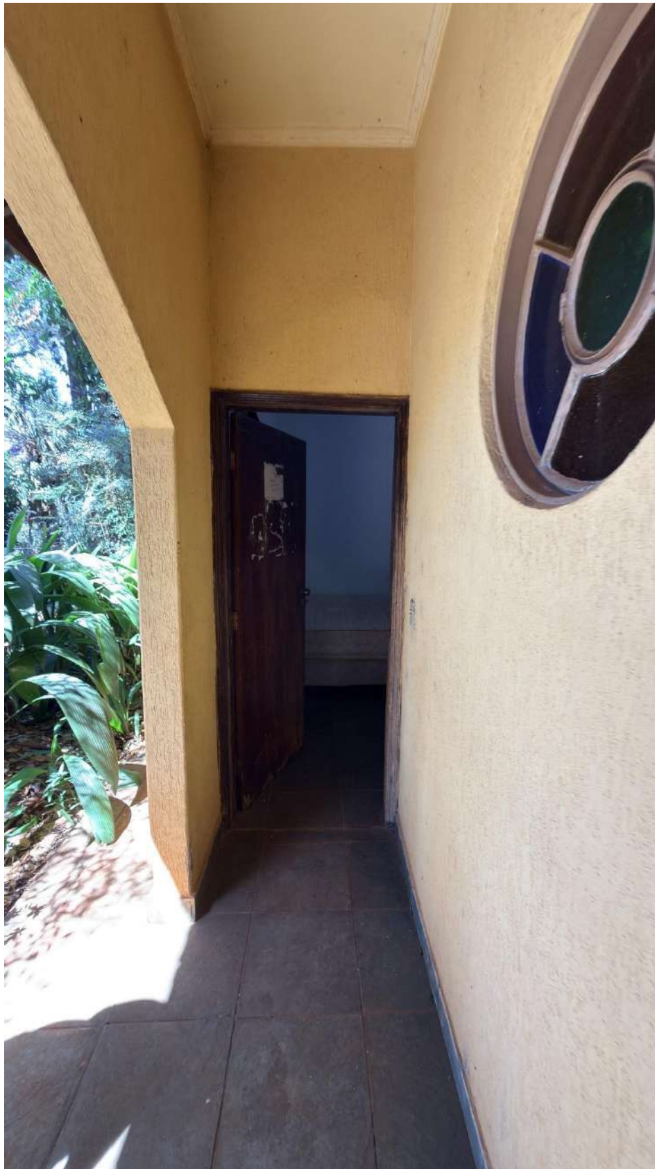
Figura 16 - Vista quarto suite 2 edícula frontal
