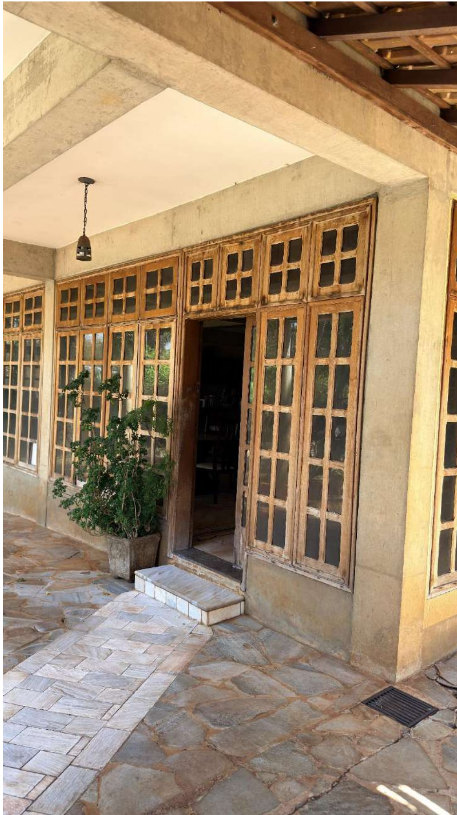
Figura 52 - Porta de entrada residência
