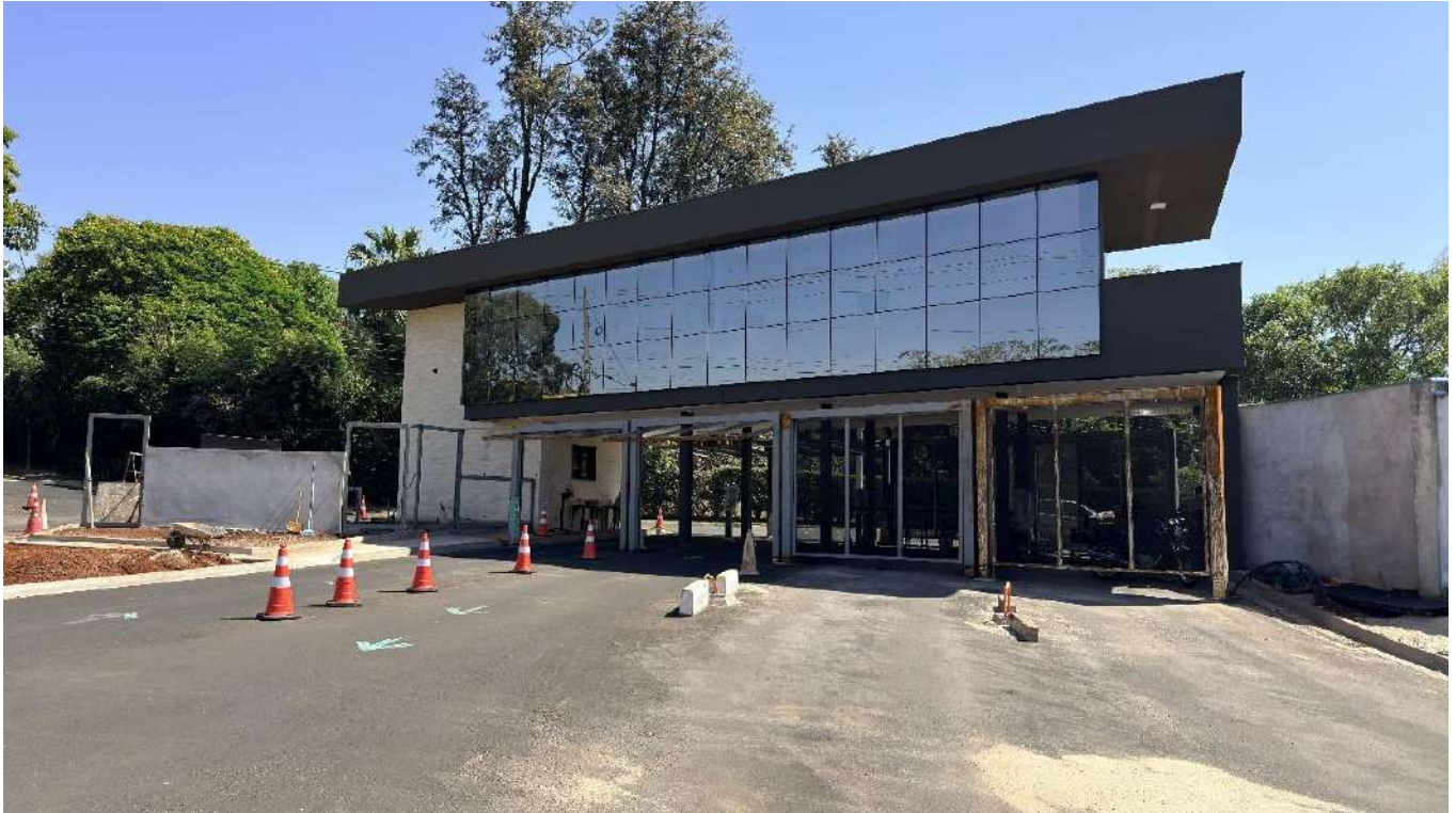
Figura 2 - Vista fachada do Condomínio Quinta da boa Vista Lado B
