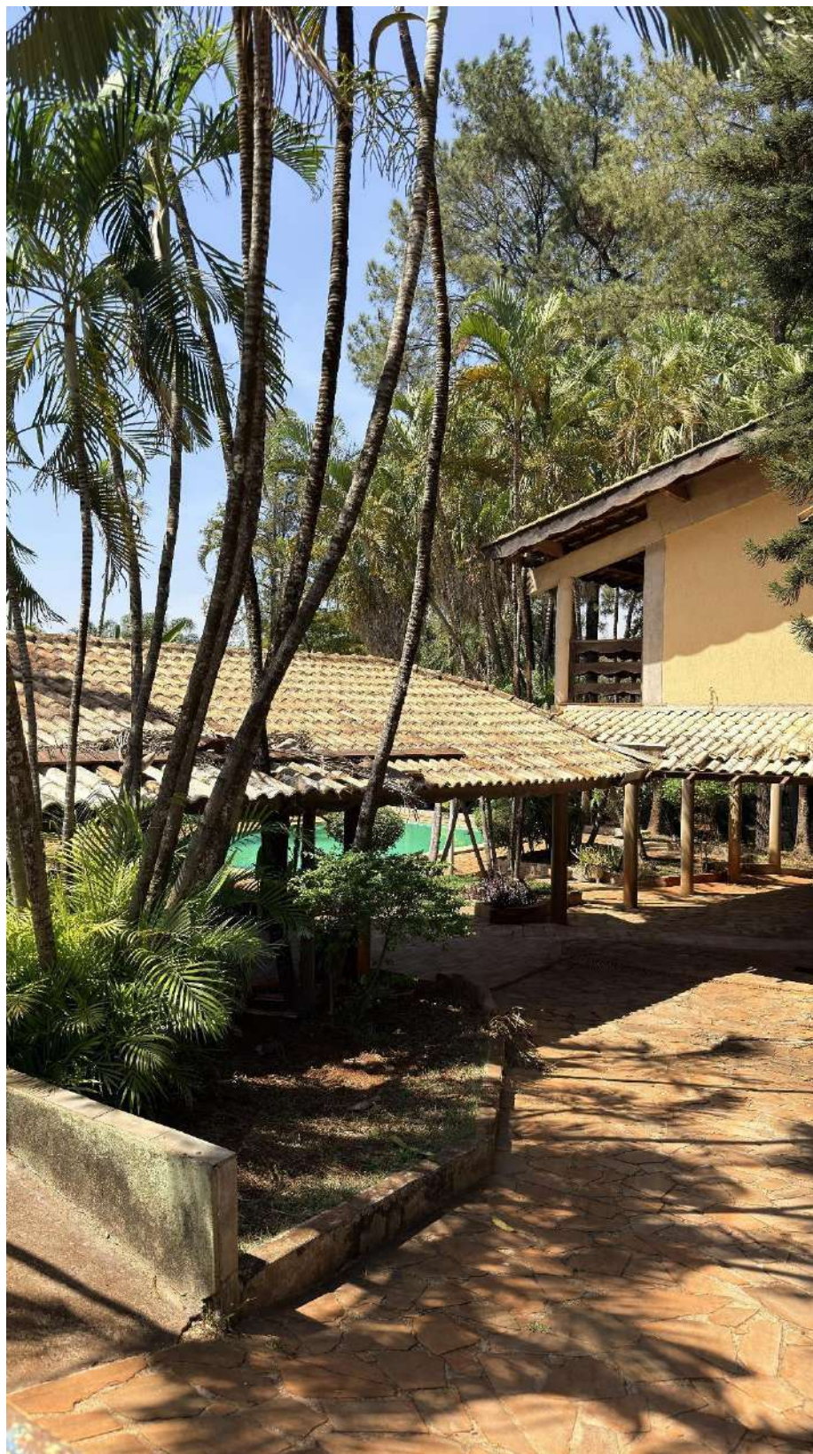
Figura 47 - Vista conexão da área gourmet com a residência principal
