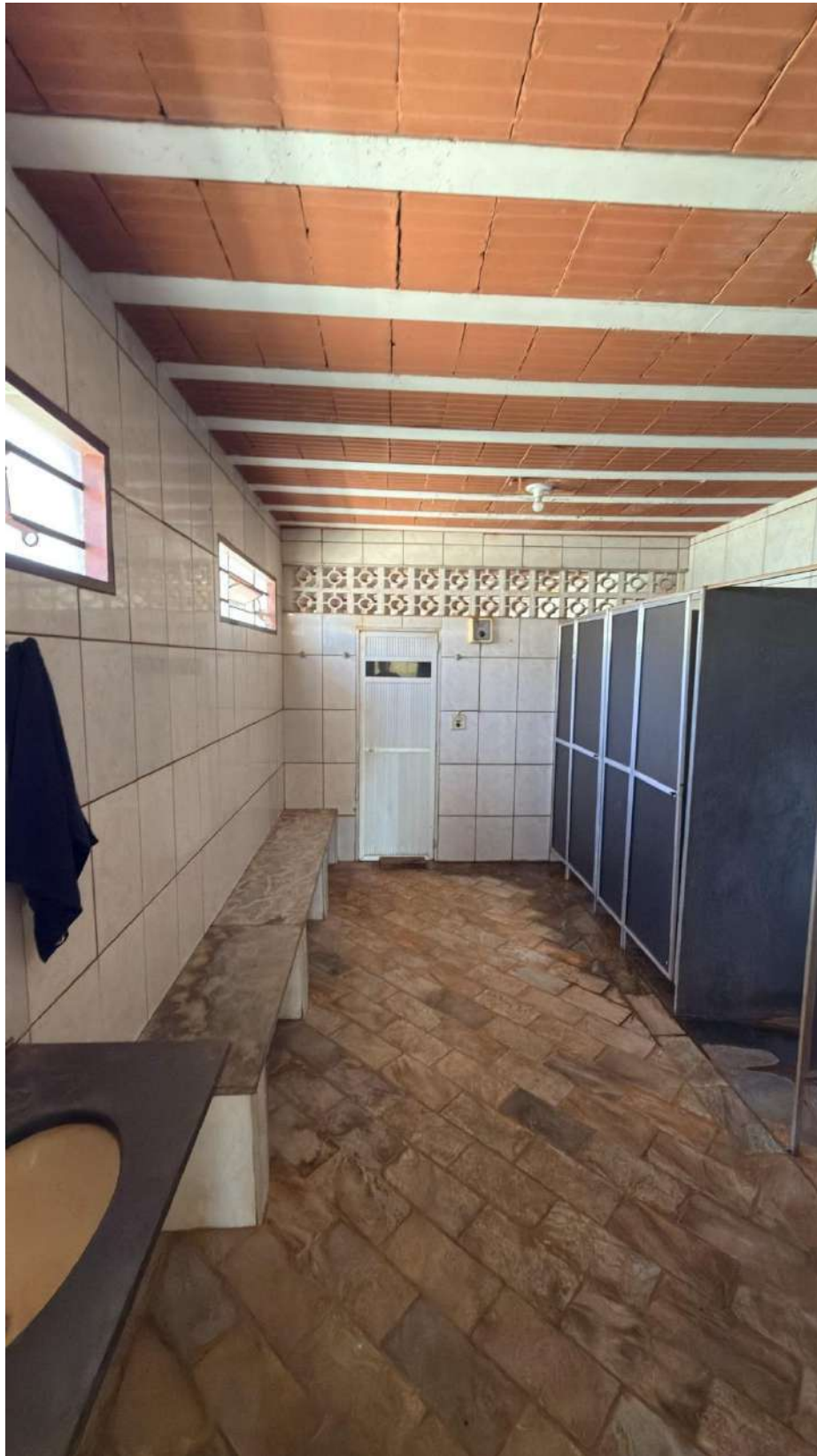
Figura 30 - Vista vestiário e sauna
