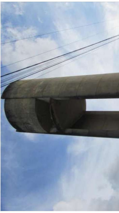
CONDOMÍNIO Aspecto Externo
