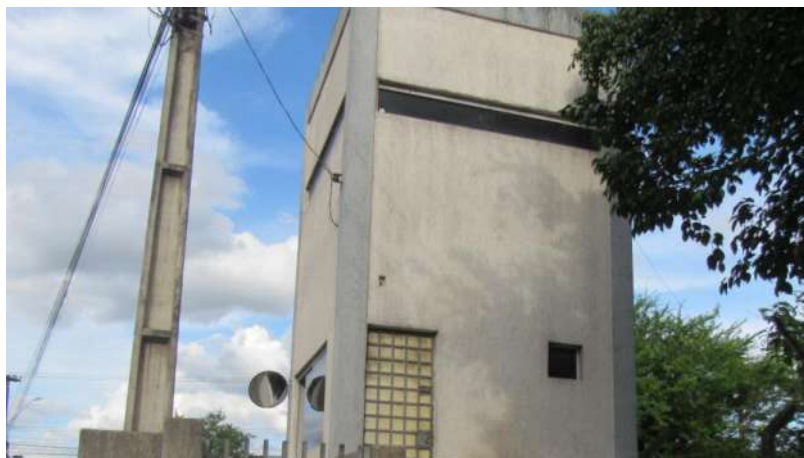
CONDOMÍNIO Aspecto Externo
