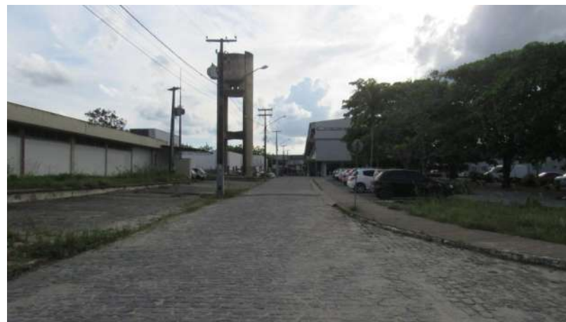
CONDOMÍNIO Aspecto Externo
