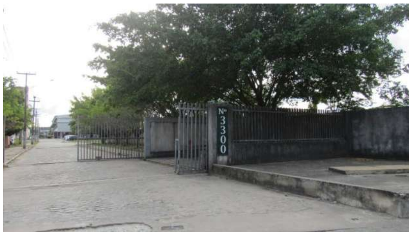
CONDOMÍNIO Aspecto Externo
