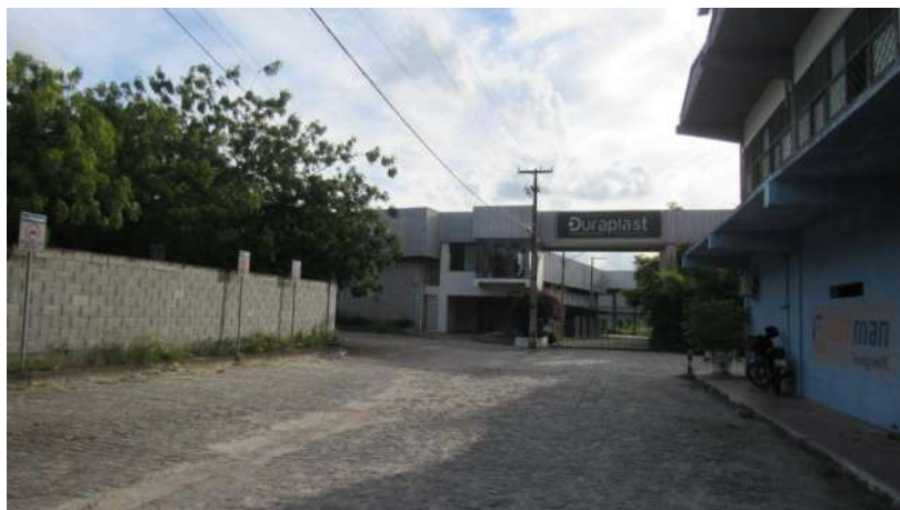
CONDOMÍNIO Aspecto Externo
