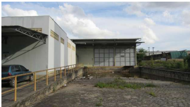
CONDOMÍNIO Aspecto Externo
