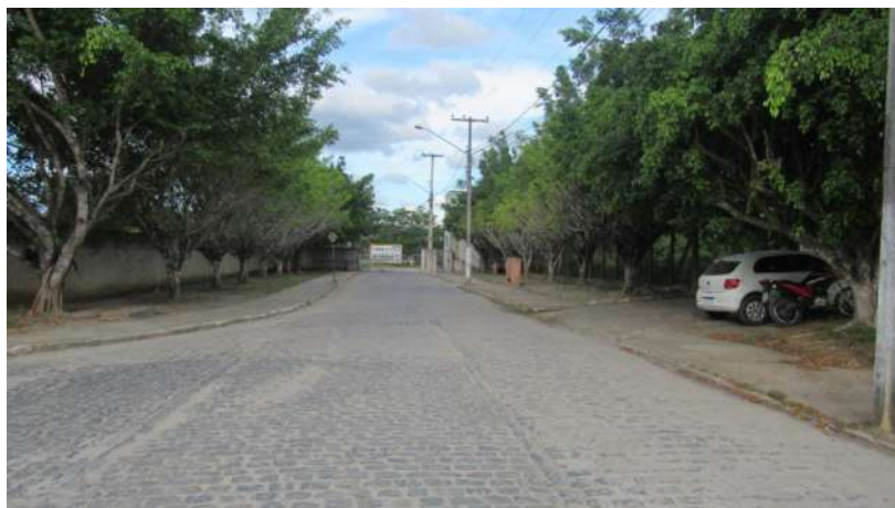
CONDOMÍNIO Aspecto Externo
