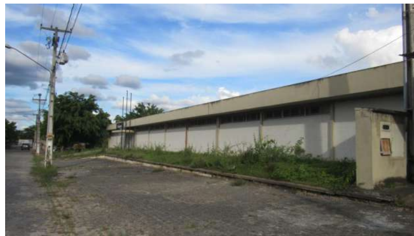
CONDOMÍNIO Aspecto Externo
