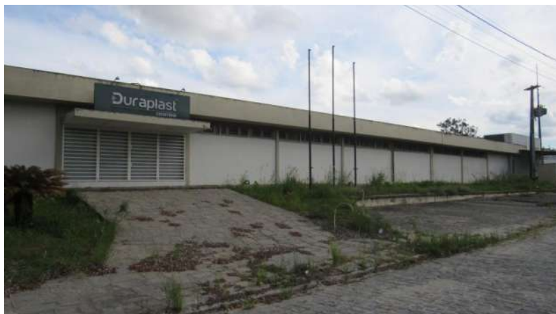
CONDOMÍNIO Aspecto Externo
