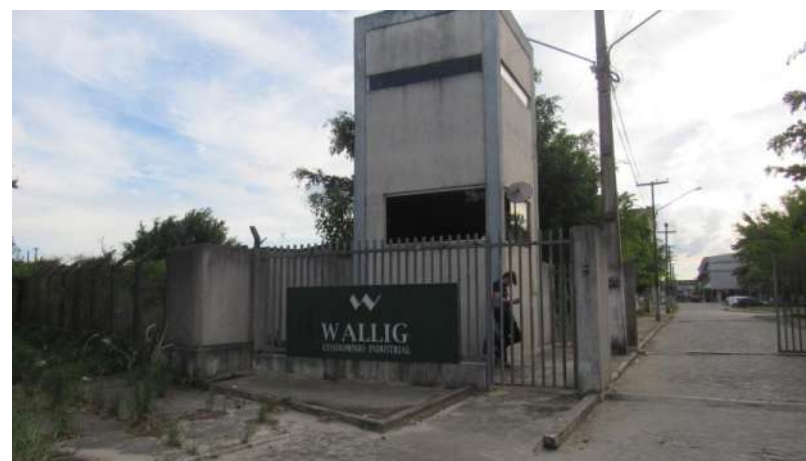
CONDOMÍNIO Aspecto Externo
