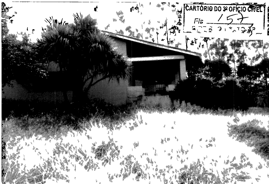
FOTO 04 BENEFITÓRIA 04 – RESIDÊNCIA 2 NÍVEIS ANEXA A ÁREA DE LAZER E PISCINA
