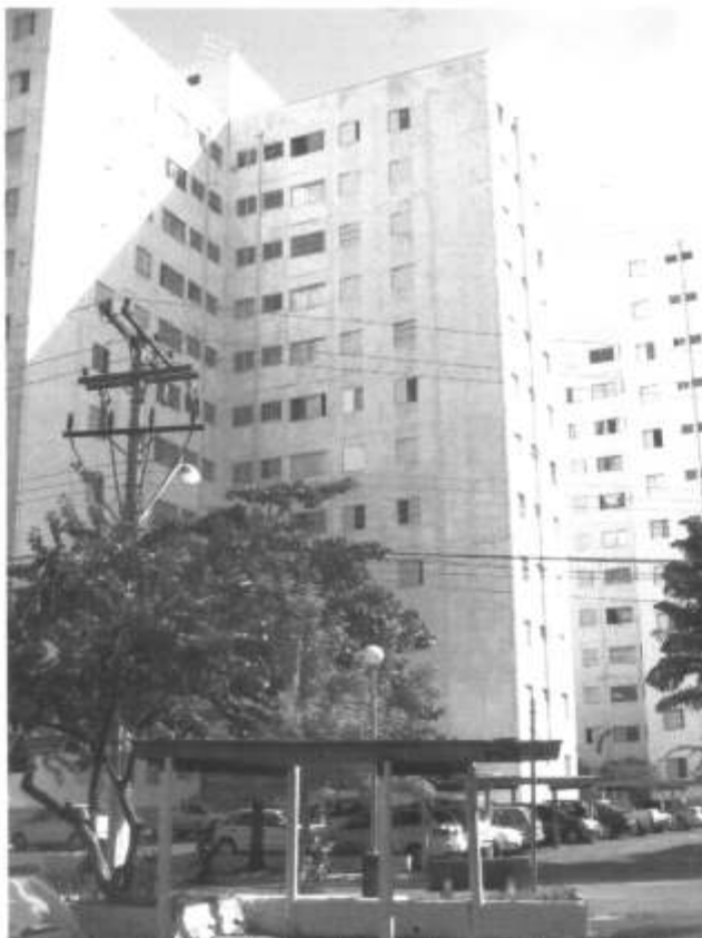
Foto 1 – Bloco A-1 do Condomínio Jardim das Pedras, onde está o apartamento periciado
