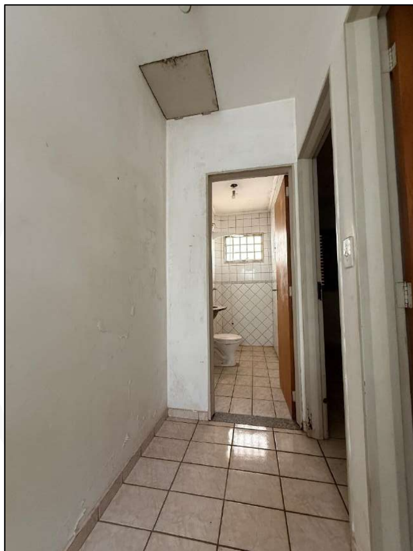
Foto 13: vista do hall de acesso aos dormitórios e banheiro.
