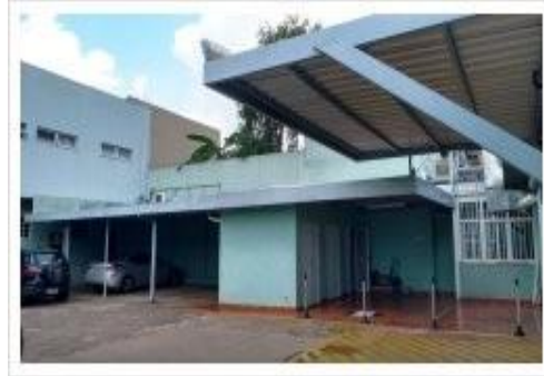
FOTO 4: Edificação estrutura metálica
