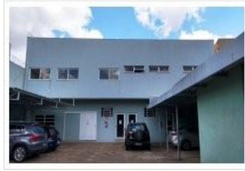
FOTO 2: Edificação nos fundos do imóvel
