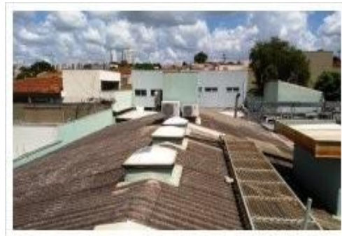
FOTO 6: Vista por cima do telhado
