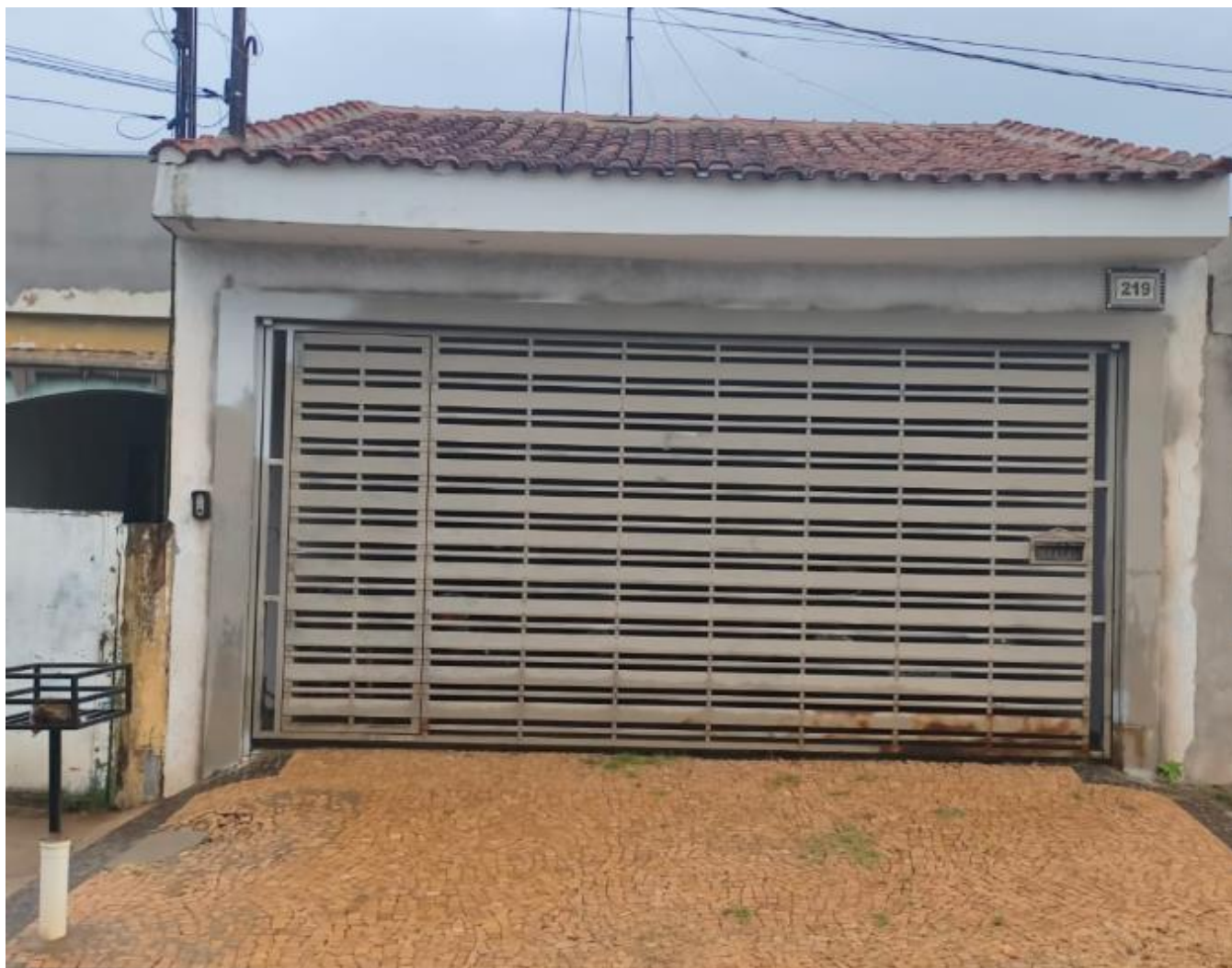
Vista frontal do imóvel avaliando
