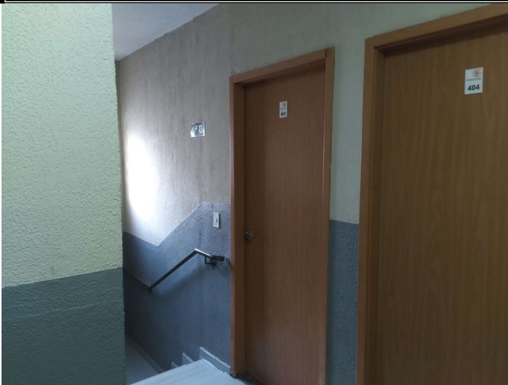
Foto 1 - Entrada do imóvel
