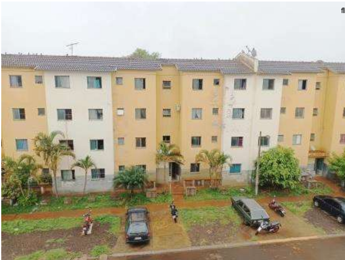
FOTO 3 Aspecto das áreas externas do condomínio e cobertura dos prédios
