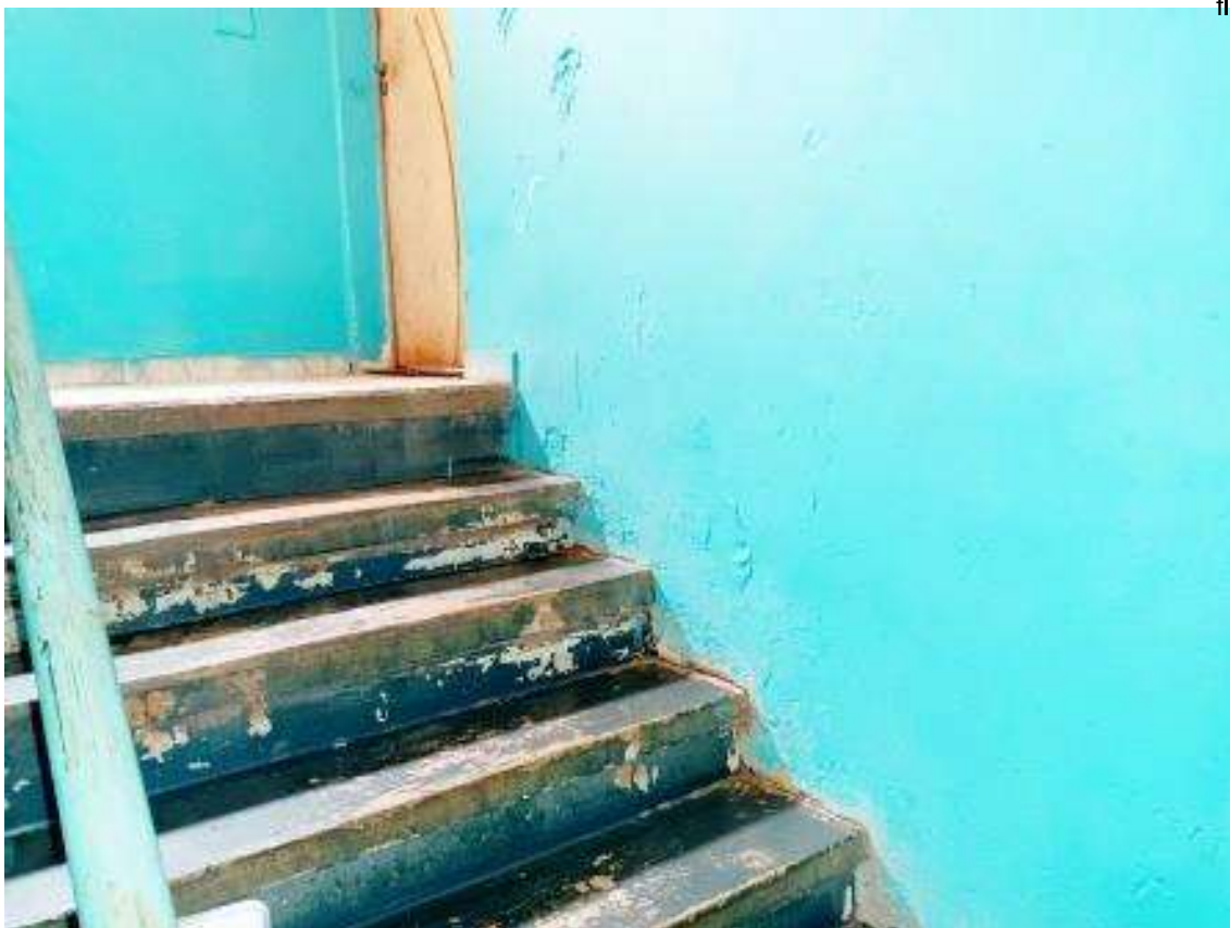
FOTO 5 Detalhe da escadaria interna do condomínio
